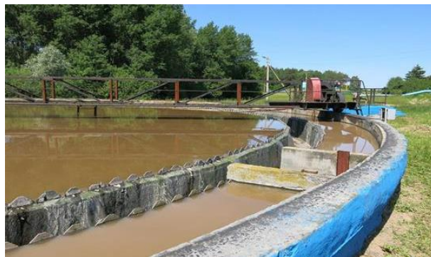
Существующие сооружения очистки сточных вод в Лиде
