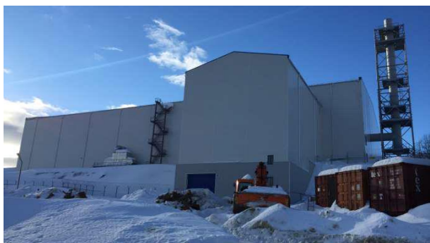
Укрытие блока сухого хранения (БСХ) в губе Андреева, где осуществляется извлечение ОЯТ и обращение с ним
